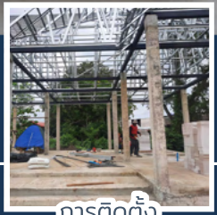
การติดตั้ง
